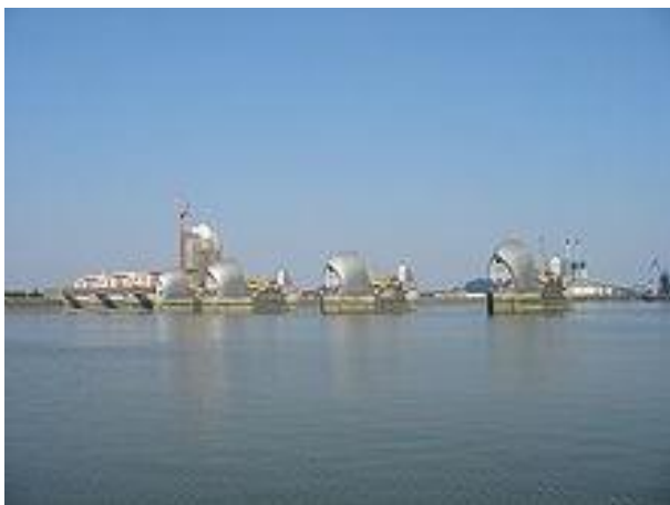
Bariéry na Temži, největší stavitelné zábrany proti záplavám na světě
